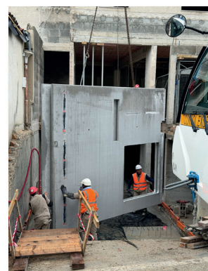
Assemblage de la tour
