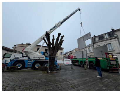
Arrivée des parties de la tour
